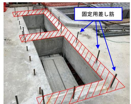
図-4 SPCa 部設置箇所(ハッチング部)
