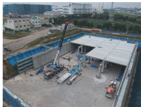
写真-1 施工状況
