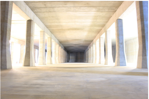
写真-2 貯水槽の完成状況
