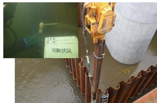
図6 潜水土による鋼矢板切断
