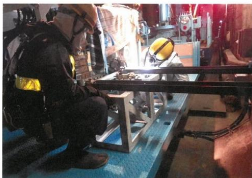
写真-3 受架台・渡し架台設置状況
