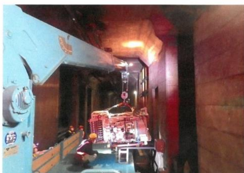
写真-2 クレーンによる吊上げ状況
