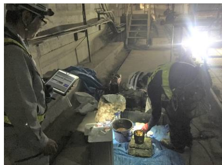
写真－1 現場適用試験
