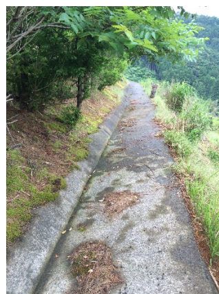
写真2 現場打ち排水路
