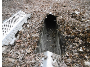
写真—6 水路内に堆積無し
