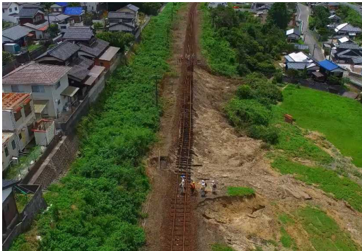
図 1 被災状況写真(起点方から終点方を望む)
