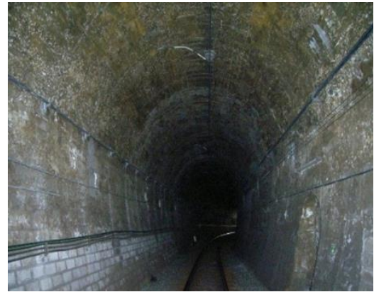
図-1 A トンネル覆工全景
