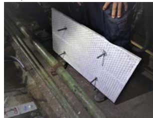
写真-1 型枠背面
