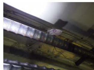
写真-3 空気抜きホース
