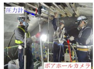
写真-4 充てん状況
