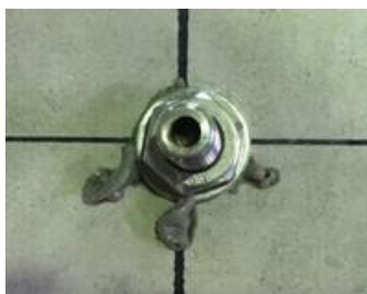
図-4 接着材の吐出状況
