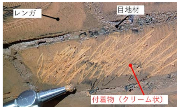
写真3 下地処理後の覆工表面
