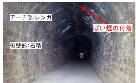
写真1 廃線レンガトンネルの状況
