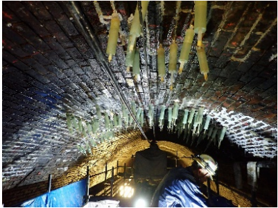
図5 IPH 工法実施状況
