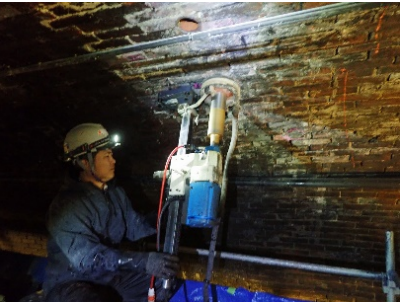
図6 コア供試体採取状況
