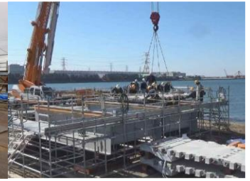
写真-2 ②床版架設 (一期施工)
