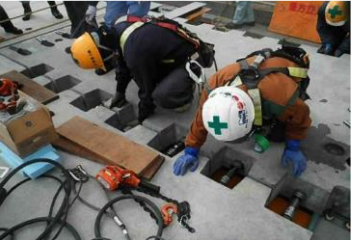
写真-4 ③PC鋼棒組立
