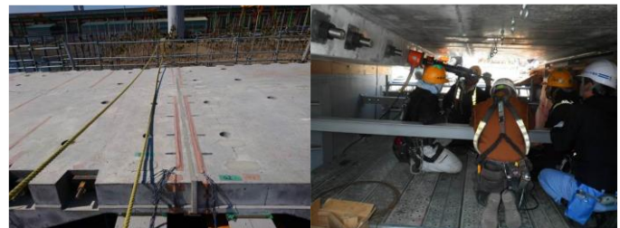
写真-7 ⑦縦目地モルタル充填完了
