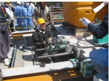
写真-6 ⑤PC鋼棒緊張
