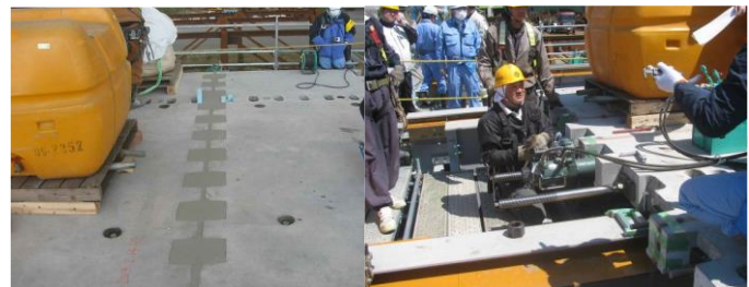
写真-5 ④横目地モルタル充填完了
