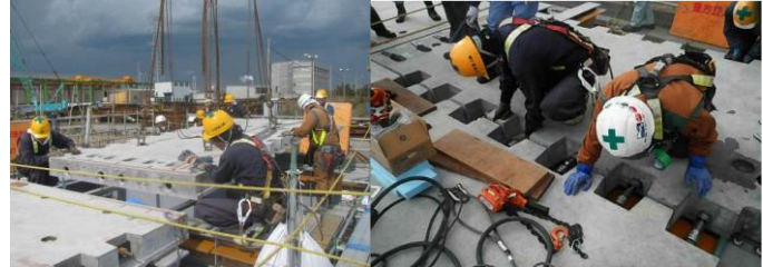
写真-3 ②床版架設 (二期施工)
