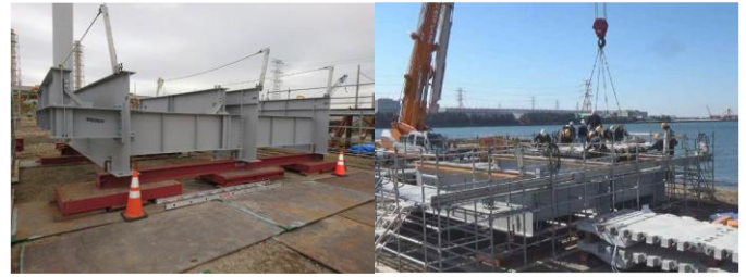
写真-1 ①準備工 (鋼桁組立)
