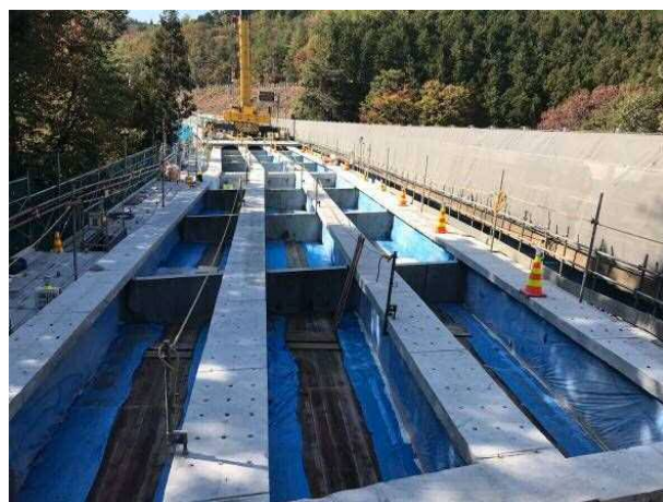
図-4 既設床版撤去完了、PCa 床版架設前
