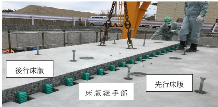
写真-1 C型コラム継手床版架設の様子
