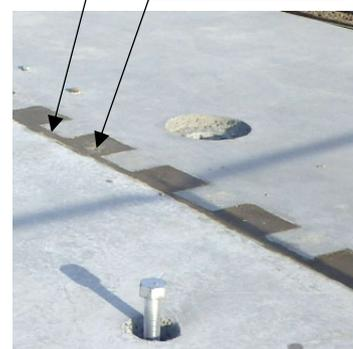
写真-3 モルタル打設後
