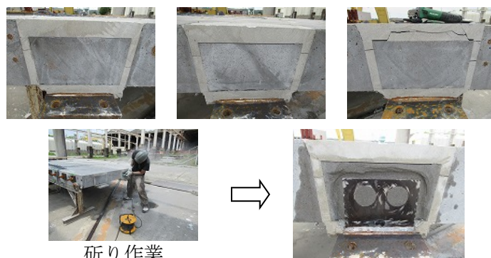
写真-2 鋼桁と床版の接合部の状況
