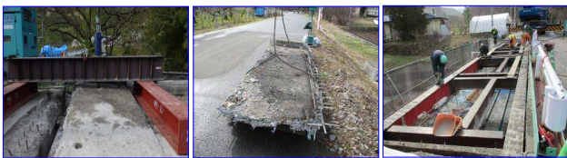
(1)RC 床版撤去 (2)床版の損傷状況 (3)鋼げたの修繕
