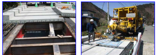
(1) 床版設置 (2) コンクリート練り混ぜ
