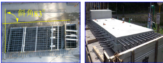
(1) 取替 RC 床版型枠 (2) 取替 RC 床版
