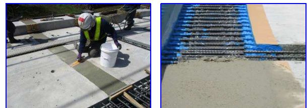
(3) 間詰部 Co 打ち込み (4) 付着用接着材の塗布
