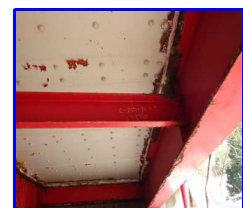
(3) 鋼板接着補強
