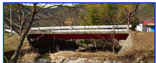
(1) 赤山橋（支間 16.1m, 幅員 7.0m, 斜角 83 度）
