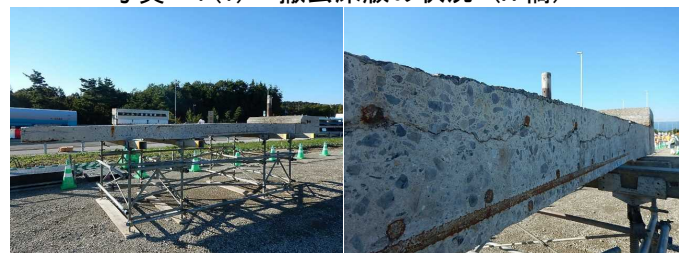
写真-1(2) 撤去床版の状況 (B橋)
