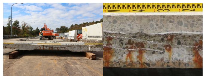
写真-1(1) 撤去床版の状況 (A橋)
