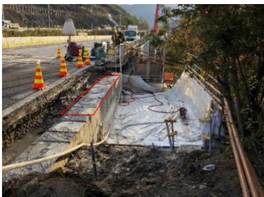
写真-2 高欄切断撤去完了
