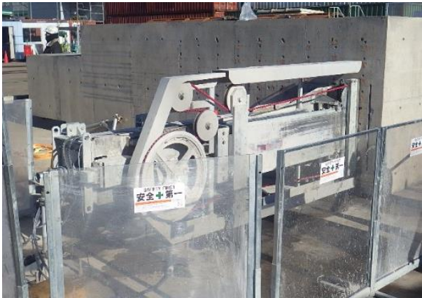
写真-1 開発工法外観写真
