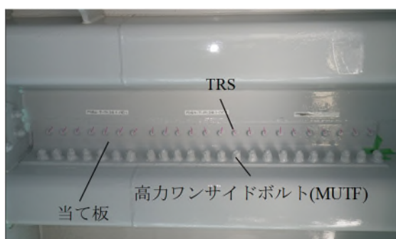
図-1 鋼床版下面当て板補修状況
