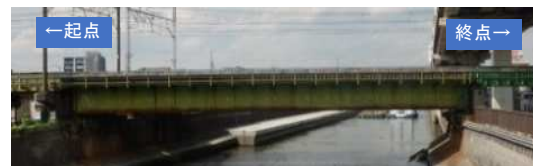
図-1 橋りょう全景
