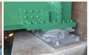
図-10 支承交換後
