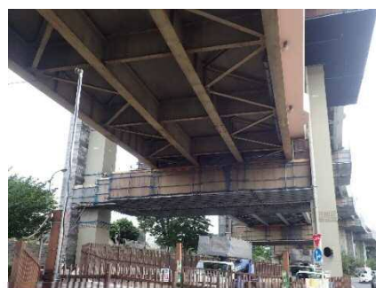
写真3 施工現場外観
