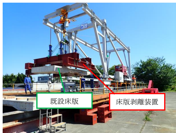
写真-1 床版撤去機と床版剥離装置
