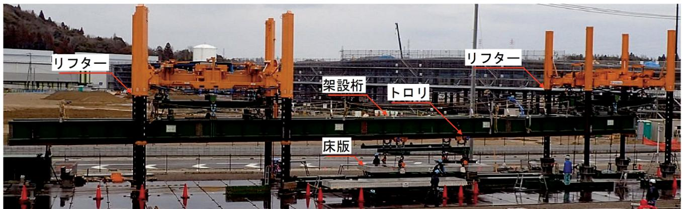
写真3 施工試験状況
