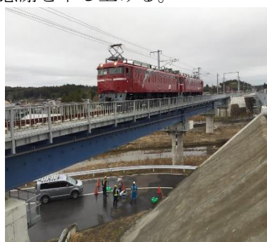
写真-4 試運転時のたわみ測定
