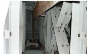
写真-4 切断後作業空間
