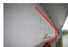
写真-2 G1 主桁外側
