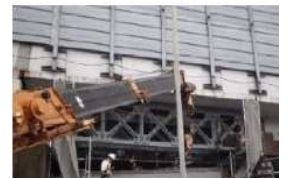
写真-5 部分取替え材取込
