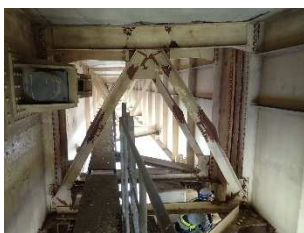
写真-1 P3 対傾構損傷 写真-2 P1 下フランジ損傷 写真-3 P4 固定支承損傷 写真-4 P5 可動支承損傷
