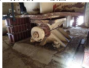
写真-1 P3 対傾構損傷 写真-2 P1 下フランジ損傷 写真-3 P4 固定支承損傷 写真-4 P5 可動支承損傷
