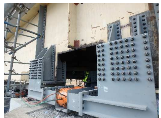
写真-5 桁切断状況
