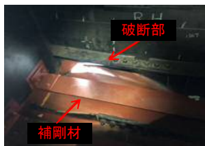
写真-3 H形鋼による梁内補強
