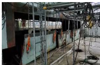
写真-4 梁撤去状況
