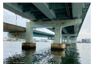
写真-6 完工写真
