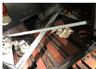
写真-5 梁内補強状況
