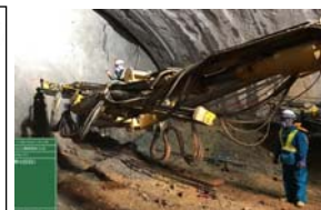
写真3 削孔検層状況
