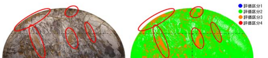
図-4 切羽画像と風化度評価結果の例
