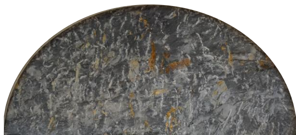
写真-2 切羽写真
