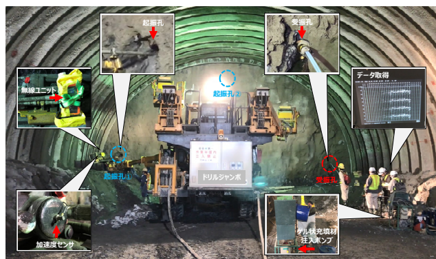
写真-1 現場試験状況
