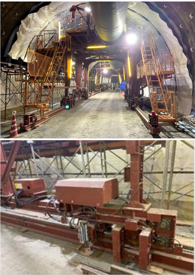
写真－1 Rail Walker System の使用状況
