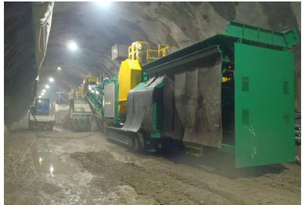
写真-2 現場導入状況
