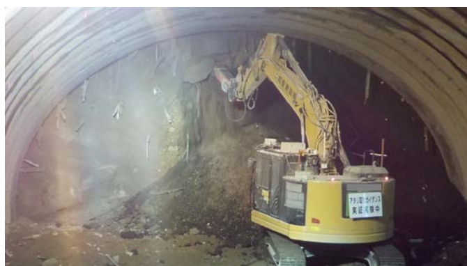
写真-2 実証試験状況
