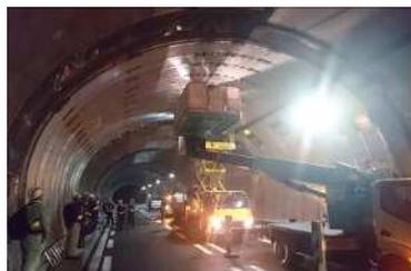
写真-7 内巻補強工
