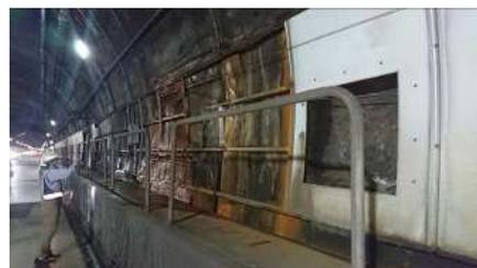
写真-9 内装パネル背面の腐食
