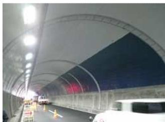
写真-6 内面補強工
