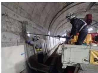
写真-2 水抜き孔削孔
