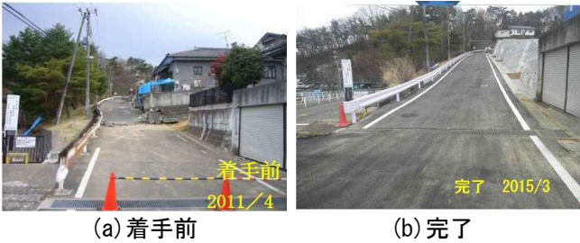
写真-1 造成宅地滑動崩落緊急対策事業
