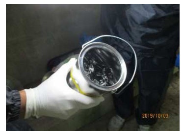
写真-4 プライマー
