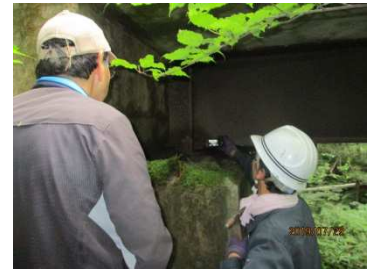
写真-1 補修実証橋梁
