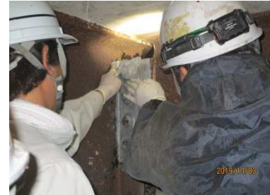
写真-7 添接部補修状況
