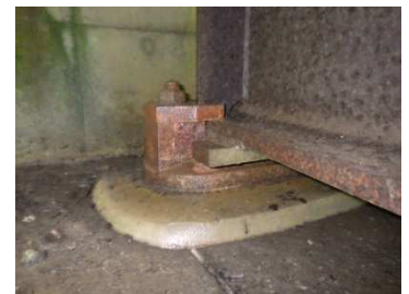
写真-2 支承状況
