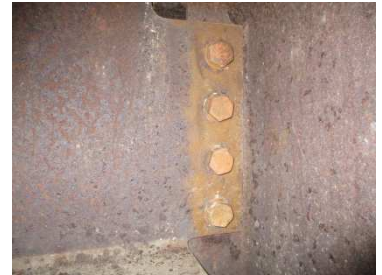
写真-5 添接部状況 （浮き錆除去後）
