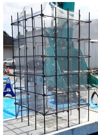
写真1 プレハブ鉄筋の状況
