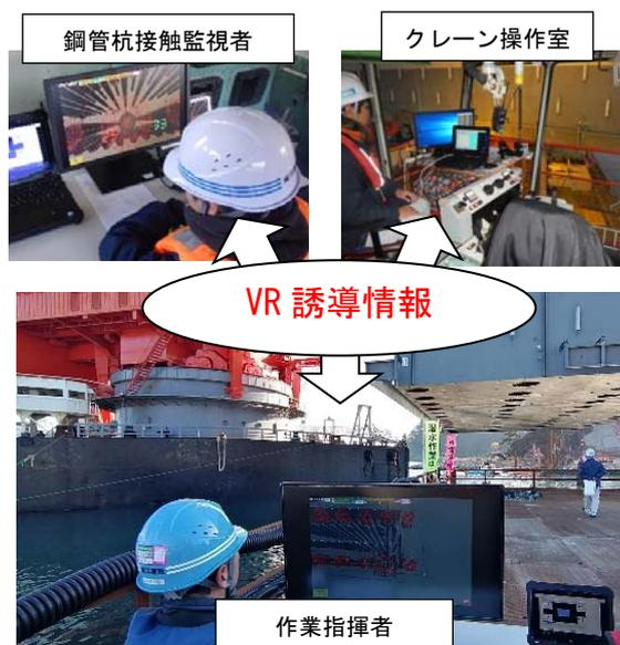
写真-3 函ナビ VR による据付け状況
