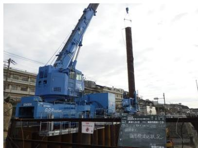
図-4. 鋼管杭の設置状況②
