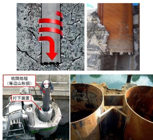
図-1. 回転切削圧入と杭間処理
