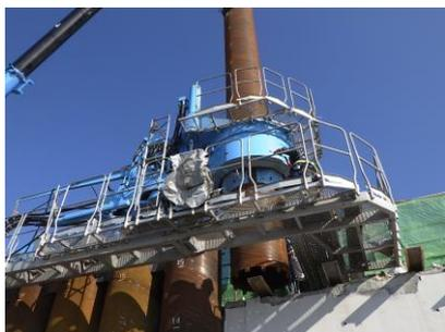
図-3. 鋼管杭の設置状況①
