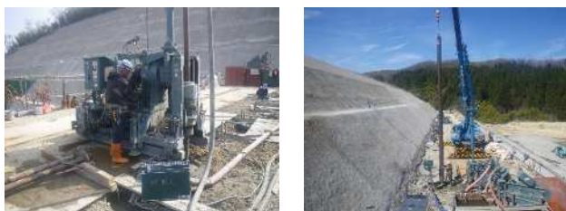
写真-6 抑止杭工施工状況（左：削孔、右：鋼管建込）
