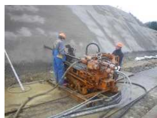
写真-5 水抜きボーリング
