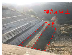
写真-4 押さえ盛土完了
