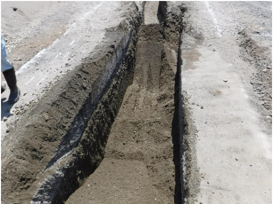
図-3 試験施工状況(2条掘削)
