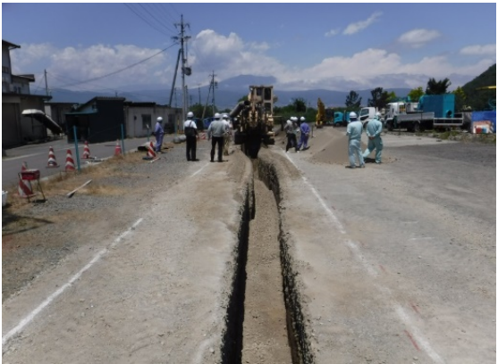
図-2 試験施工状況(1条掘削)
