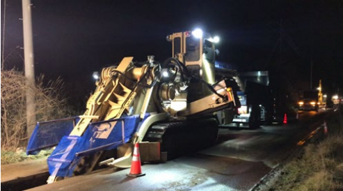
図-5 実施工状況
