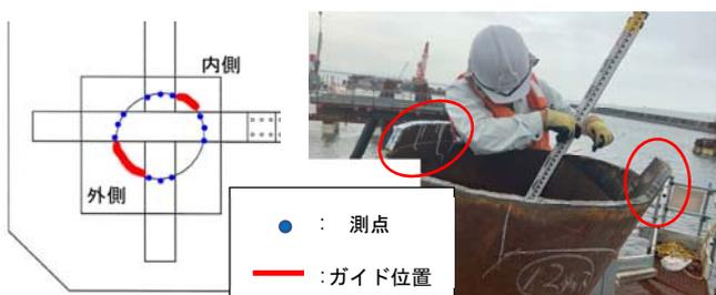
図-5 架設用ガイド配置、形状
