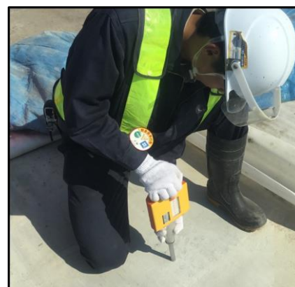
写真－3 テストハンマー試験状況
