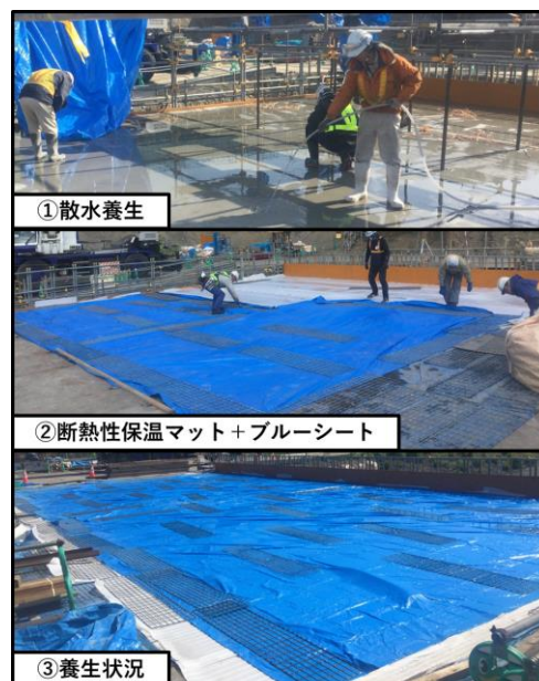
写真－2 表面養生状況
