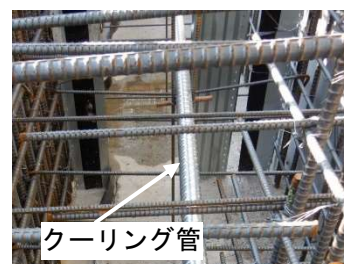
写真-3 クーリング管設置状況
