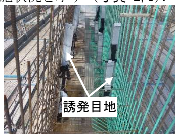
写真-1 誘発目地の設置状況
