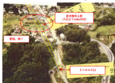
写真-4 トンネル上部利用状況 (1997/畑)
