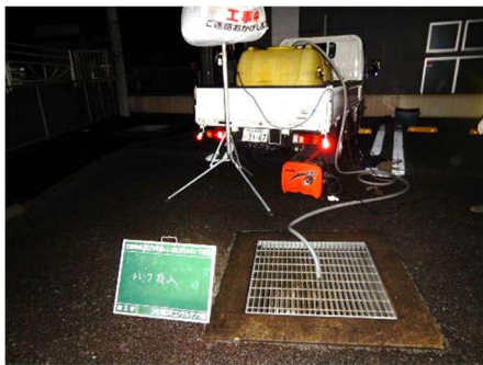
写真-8 トレーサ試験状況
