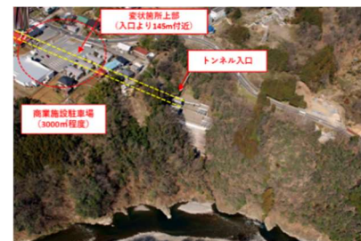
写真-5 トンネル上部利用状況 (2004/商業施設)
