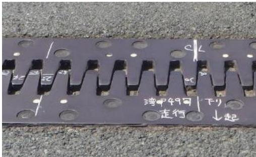
図1 鋼製フィンガージョイントの例
