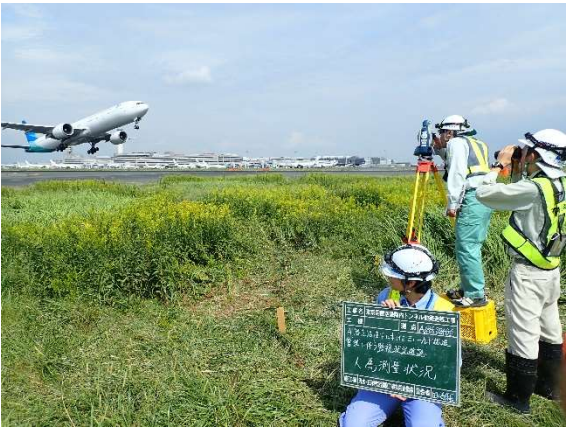
写真-3 A 滑走路人為測量状況
