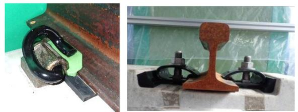
(a) 線ばね形 (b) 板ばね形
